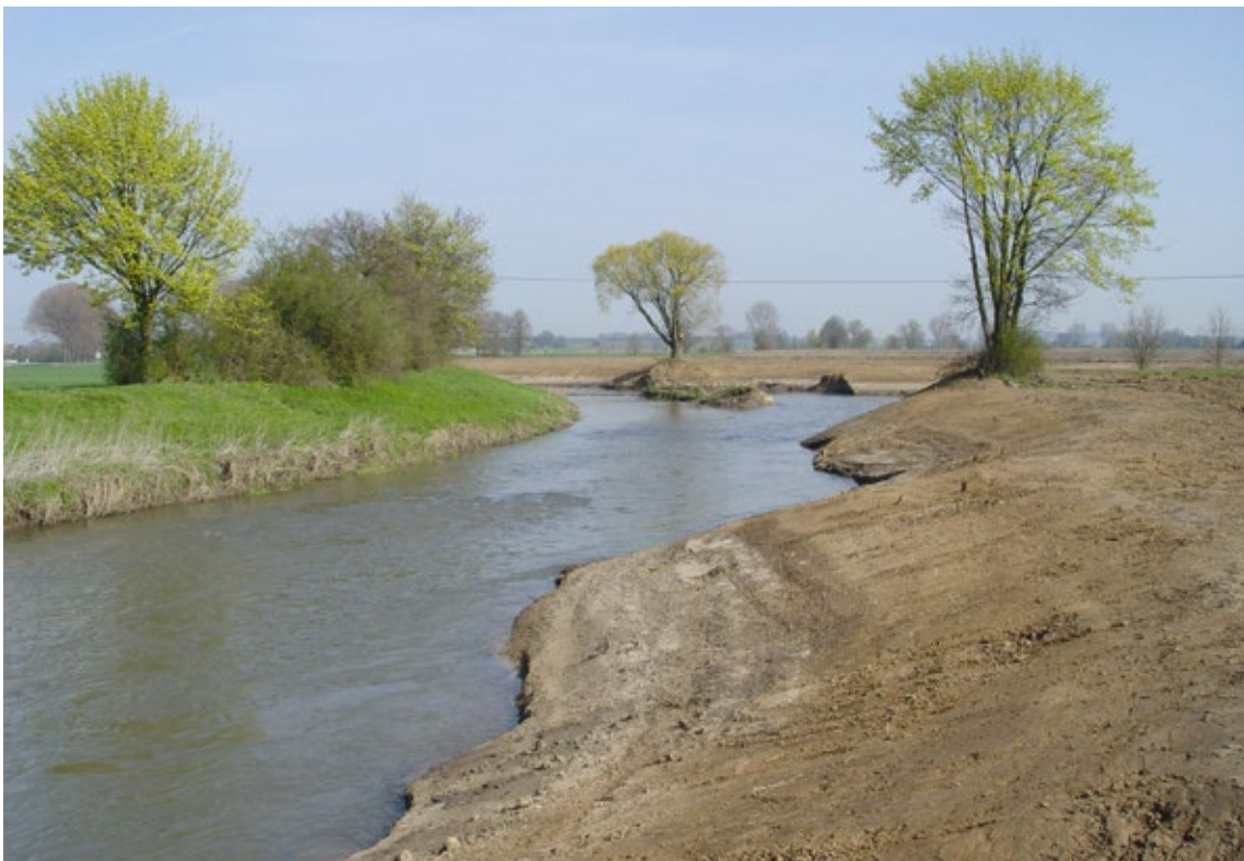
Renaturierung der Nidda: Entfernung des Deiches, Abflachung des Ufers und Anschluss der Aue.
